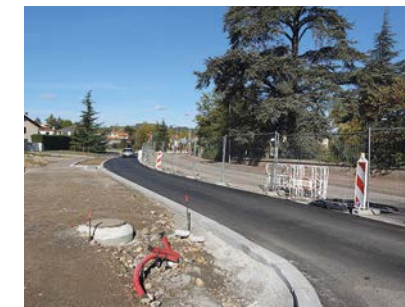
> Le chantier avance
