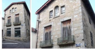
1_ Maison remarquable Balcons en fer forgé "Serlienne" (triple baie avec un arc en plein cintre au centre).
