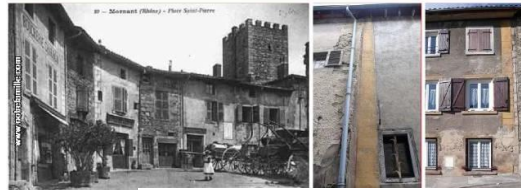
3_ L'Hôtel des Postes, de la Justice et de la Paix, construit entre 1902 et 1905.
