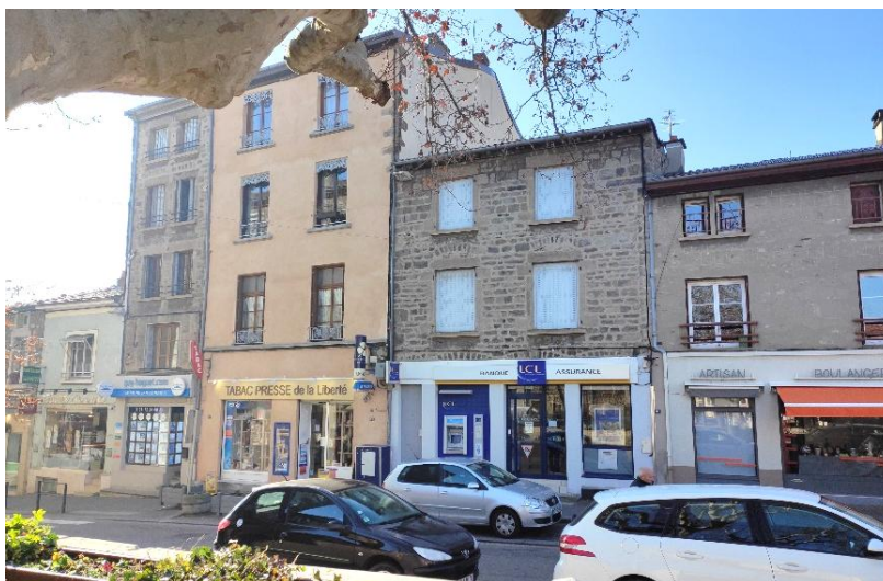
Linéaire commercial rue de Lyon
