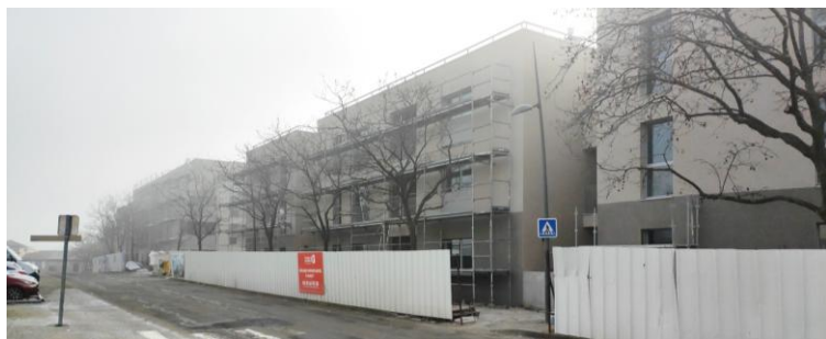
Opération en cours, à l'Ouest et au centre du secteur
