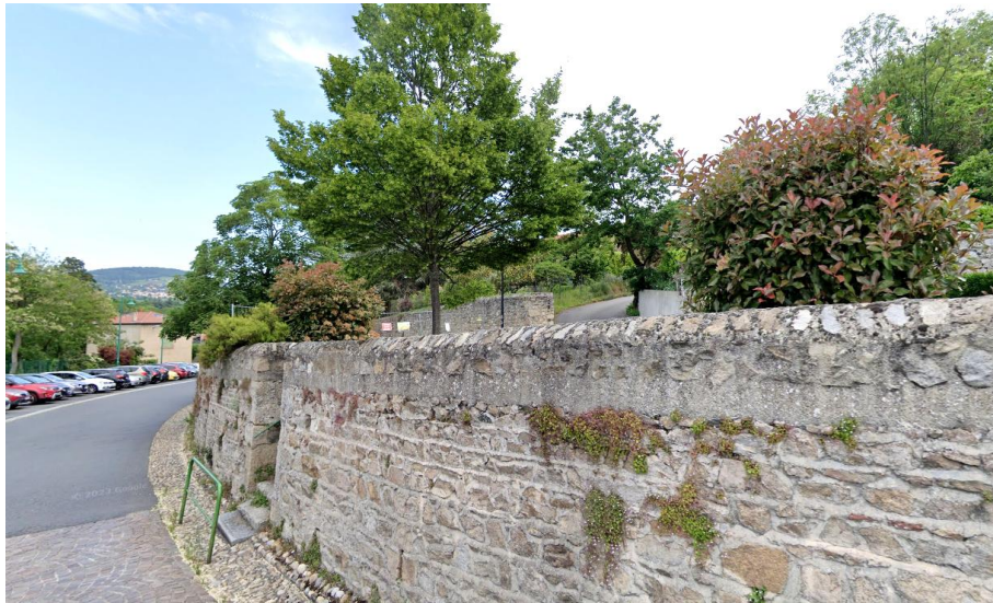
Accès au secteur depuis la Route de Saint-Sorlin
