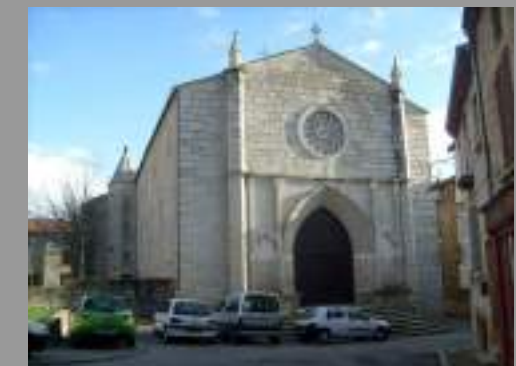
La tour de la Dîme et l'église (a, b)
