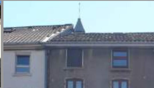
Fenêtres sans battant, avec une division horizontale et châssis fixe à proscrire
