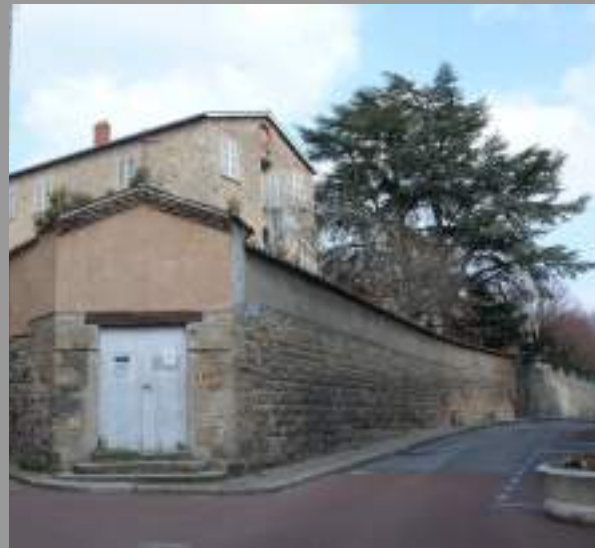
Mur de clôture d'un jardin, couvert en dos d'âne — à conserver et à reproduire Mur en pierre surélevé et couvert de tuiles scellées — à conserver et reproduire (mis à part la finition de l'enduit : voir à ce sujet les finitions des façades).
