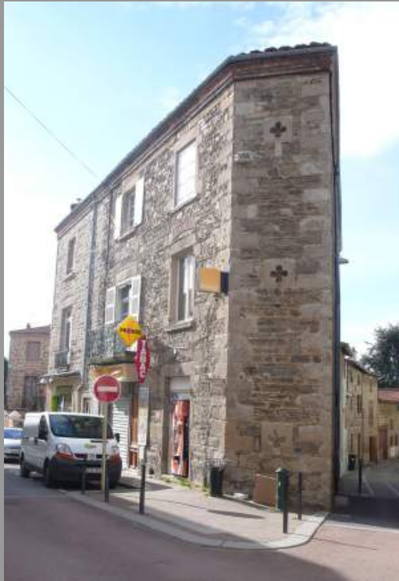
Distributeur intégré dans la façade, à proscrire Profusion des caissons lumineux, à limiter : ils ne doivent pas dépasser l'allège du 1er étage (orange et presse non conforme).
