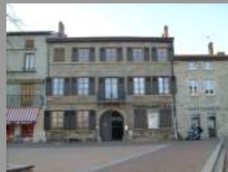
Balcon étroit en pierre de taille et consoles et garde-corps ouvragé, à conserver
