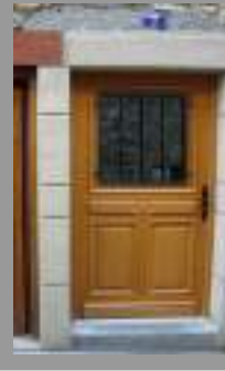
Appuis en béton à proscrire Pierre reconstituée à proscrire
