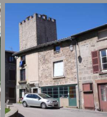
Rez-de-chaussée remaniés et remaniable
