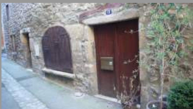
Rez-de-chaussée témoignant de la présence d'une ancienne boutique : à conserver
