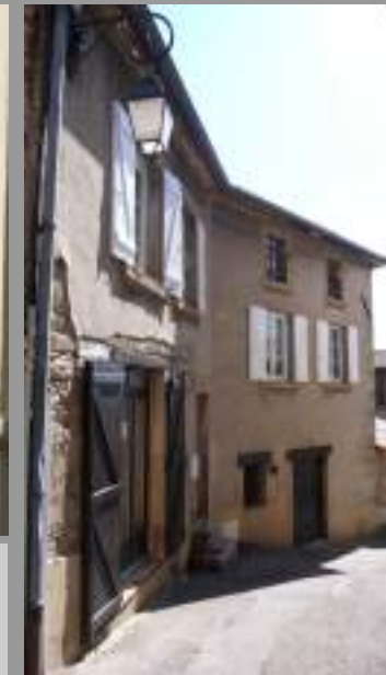
Persiennes avec un vantail pliable et jalousies inclinables à conserver, à restaurer et à reproduire
