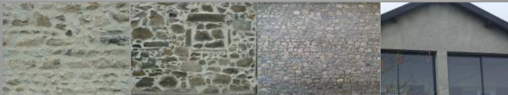
Joint plein au mortier de chaux et sable de rivière à reproduire
