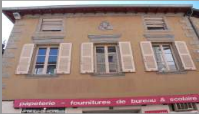
Façade enduite et peinte en trompe l'œil. Le décor représente les chaînes d'angles, les encadrements de baie et un médaillon.
