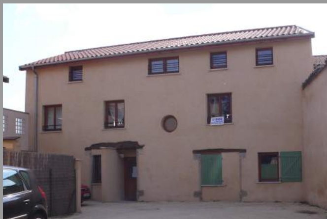
La multiplicité des formes d'ouvertures (carrées, rondes...) est à éviter. La division des propriétés par un mur perpendiculaire à la façade est strictement interdite.
