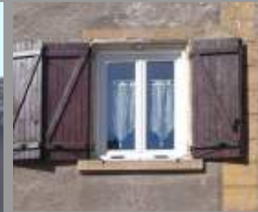
Fenêtre PVC à proscrire Volet "z" à proscrire
