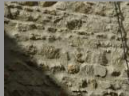
Rejointoiement à ras de maçonnerie de moellons
