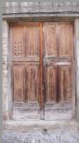
Porte bois à deux vantaux moulurés à conserver
