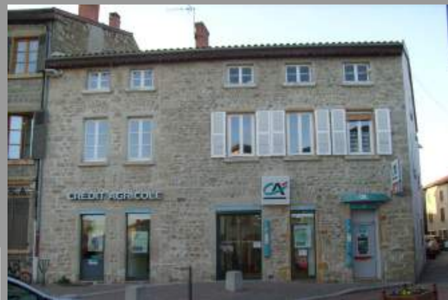
Traitement différencié du commerce et des étages privés correctement traité, avec lettres individuelles découpées, à reproduire L'enseigne lumineuse rue de Lyon déborde sur le 1er niveau.
