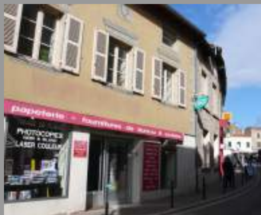
Rez-de-chaussée disparate (l'enseigne imprimée, les ouvertures métalliques non homogène), mal intégré à l'architecture, à proscrire. Enseigne « relais colis » trop haute
