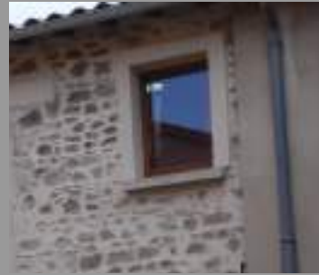
Fenêtres en bois à un seul battant et sans subdivision, à proscrire pour des dimensions supérieures à 40x70
