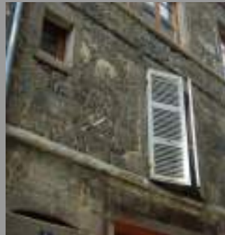
Encadrements en pierre de taille et en bois Encadrement en trompe l'œil et appui saillant en pierre de taille conseillé.
