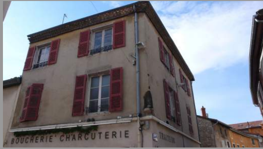
Fenêtres menuiseries bois, structure à deux vantaux et petits bois (pour d'autre exemple voir zone 1)
