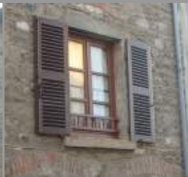
Ouverture du rez-de-chaussée reprise en béton : à proscrire
