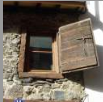
Encadrements en pierre de taille et en bois Encadrement en trompe l'œil et appui saillant en pierre de taille conseillé.
