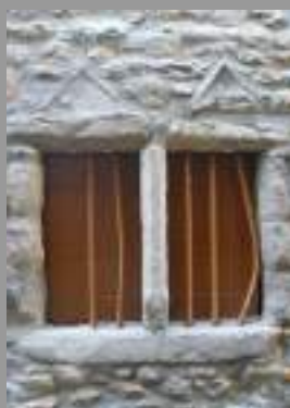
Fenêtre à meneau et arcs de décharge en bois
