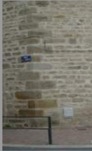
Chaîne d'angle et pierre apparente dans le même plan à réaliser
