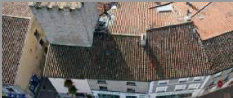
Couverture en tuiles canal creuses ton rouge vieilli et rouge
