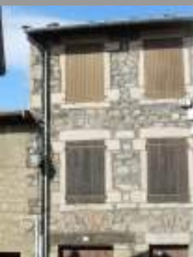
Joints rubanés, joints tirés au fer, joints ciment, joints en creux et joints beurrés : tous ces exemples sont à interdire
