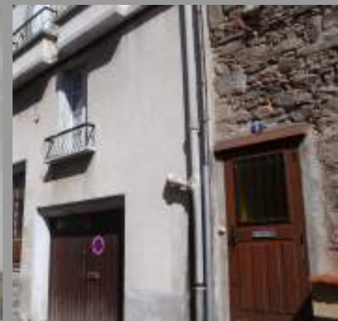
Portes semi-vitrées et porte de garage en bois
