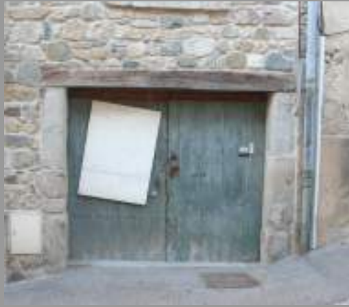
Linteau bois et encadrement pierre de taille : à conserver et à reproduire
