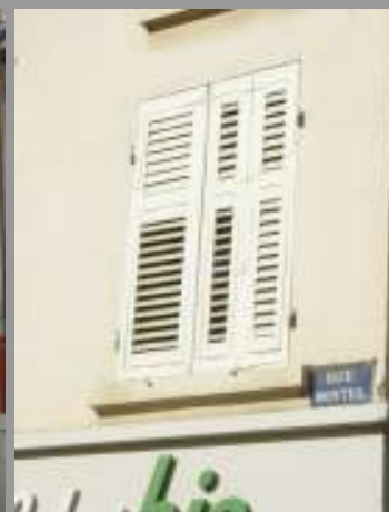
Persiennes avec un vantail pliable et jalousie inclinable à reproduire
