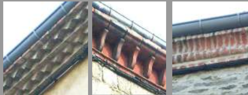
Dépassées de toiture : Génoise à 5 lits Corniches en terre cuite
