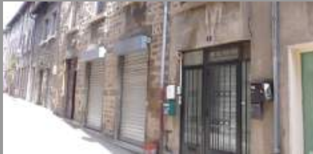
Volets roulants métallique avec coffre extérieur, à interdire — Au premier plan, le volet métallique intérieur, en partie masqué, est accepté
