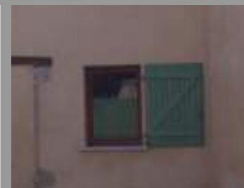
A droite : Les volets Z et volet à un seul battant (pour une dimension supérieure à 40 cm de large) sont proscriés.
