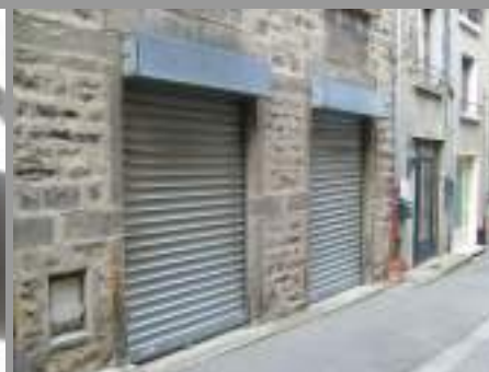
Volet/porte de garage roulant métallique à interdire
