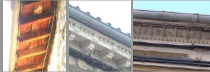
Dépassée de toiture traditionnelle: voligeage et chevrons
