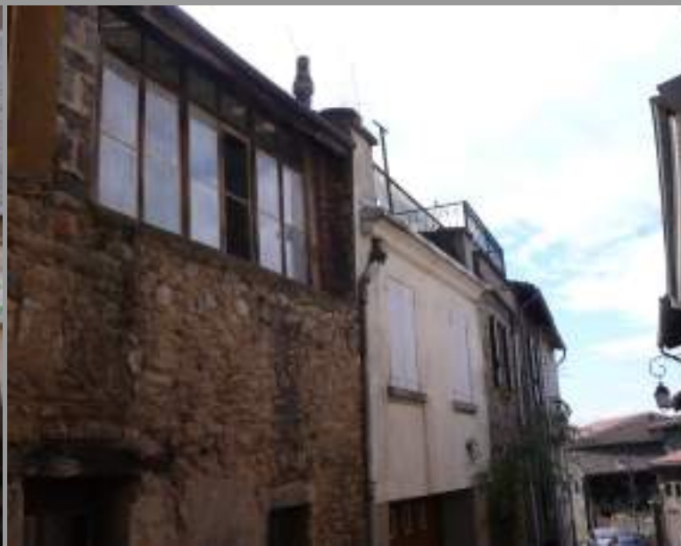
Verrières avec menuiserie bois ou fer à T (très fine) sont autorisées côté cour ou côté jardin, elles ne seront pas acceptées côté rue.
