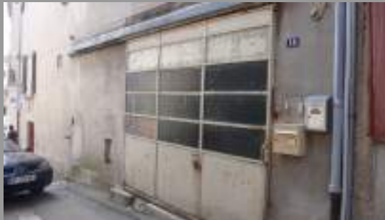
Porte métallique sur rail extérieur à proscrire
