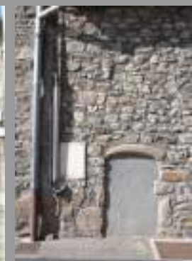
Joints rubanés, joints tirés au fer, joints ciment, joints en creux et joints beurrés : tous ces exemples sont à interdire
