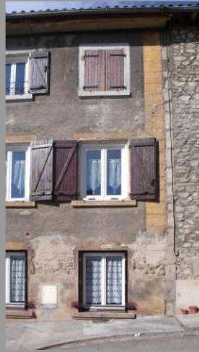
Chaîne d'angle en trompe l'œil sur enduit à encourager sur les façades enduites
