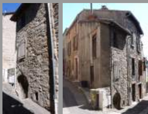
Porte à demi enterrée avec son escalier (menant à la cave) sur l'emprise de la voie publique : à conserver
