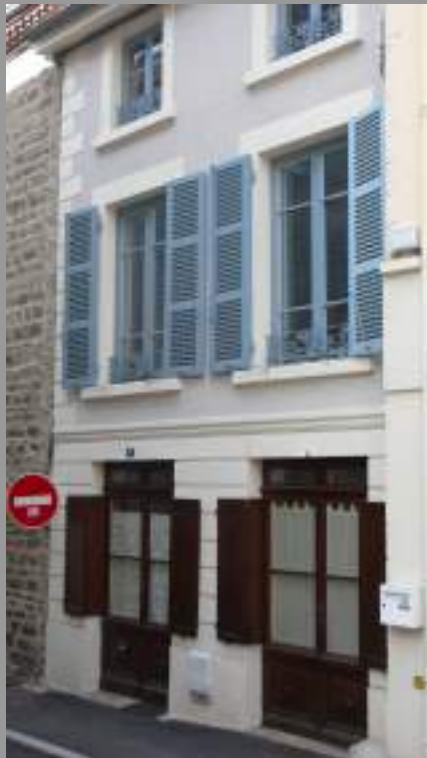
Fenêtre Persiennes (1er étage) et volets pleins pliables en bois (RDC)
