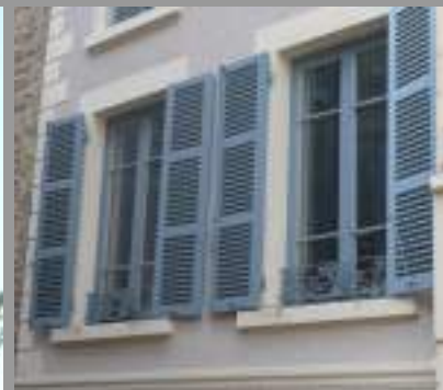
Garde-corps ouvragés finement et dans l'embrasure de la baie à maintenir
