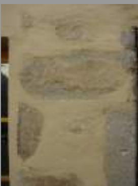
Joints rubanés, joints tirés au fer, joints ciment, joints en creux et joints beurrés : tous ces exemples sont à interdire
