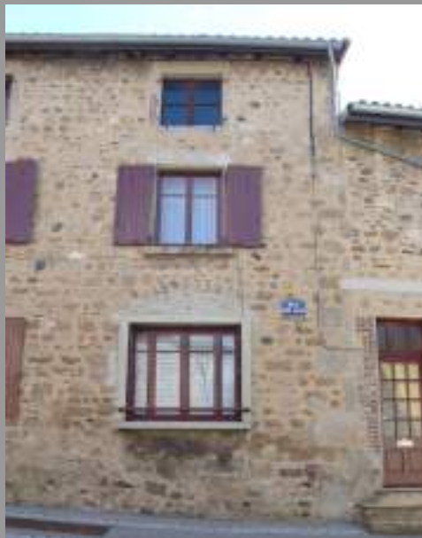
Ouverture du rez-de-chaussée reprise en béton : à proscrire
