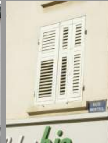
Persiennes avec un vantail pliable et jalousies inclinables à conserver, à restaurer et à reproduire
