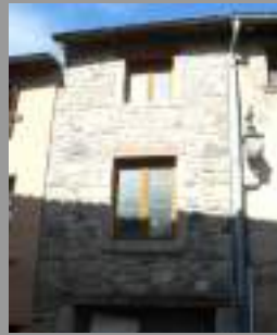
Fenêtre sans subdivision horizontale chaîne d'angle
