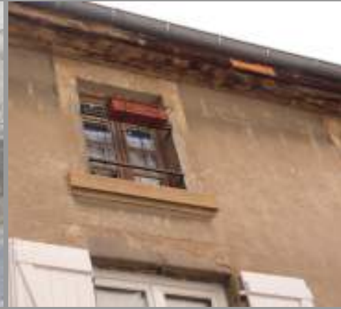
Encadrement en trompe l'œil sur enduit et appui saillant en pierre de taille
