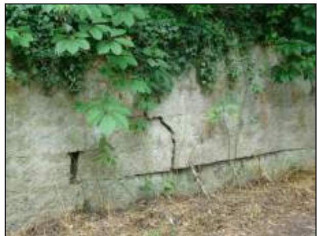
Figure 19 : Mur de soutènement très fissuré (du fait de la poussée des terrains) en bas du chemin des Bines [Source : IMS RN ]
