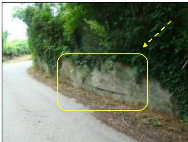
Figure 19 : Mur de soutènement très fissuré (du fait de la poussée des terrains) en bas du chemin des Bines [Source : IMS RN ]
