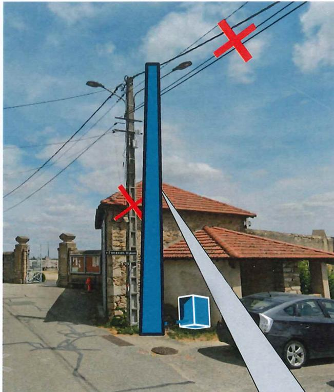
Pose d'un coffret électrique encastré et d'un support béton en arrêt
