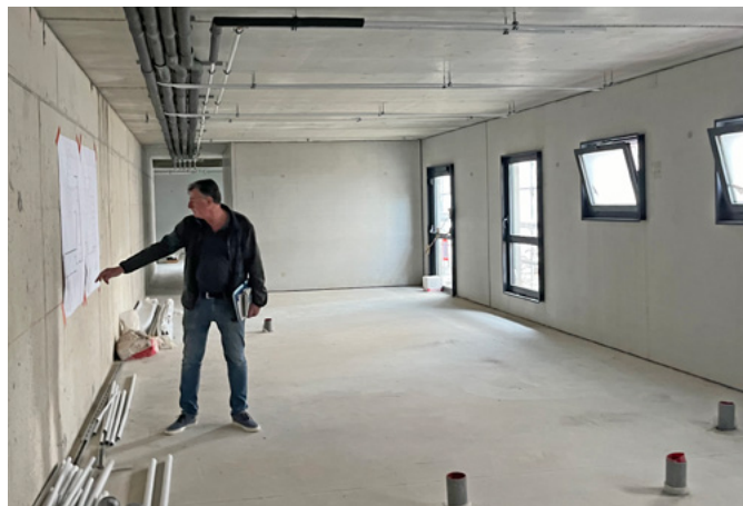
➤ Les murs de l'extension sont sortis de terre
