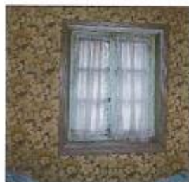
5.2 – Fenêtres anciennes en simple vitrage très vétustes
