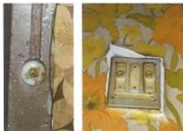
7 – Installation électrique vétuste et non sécurisée
