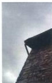
3.2 - Gouttière percée, Encombrée de végétaux
