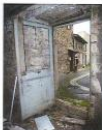
5.3 - Portes en très mauvais état n'assurant plus le clos
