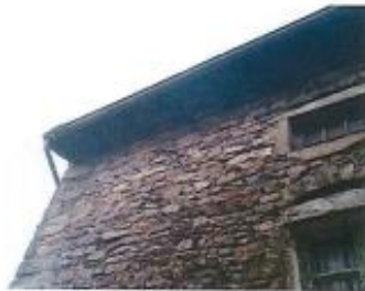
4.1 – Joints des pierres des façades en mauvais état, n'assurant plus l'étanchéité
